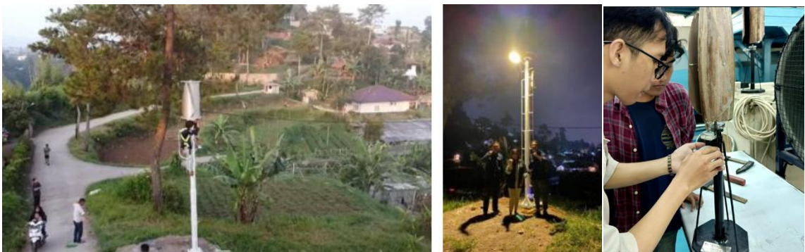
Gambar 30 Produk penelitian dan pemasangan turbin angin dari pelepah lontar untuk penerangan lampu jalan
